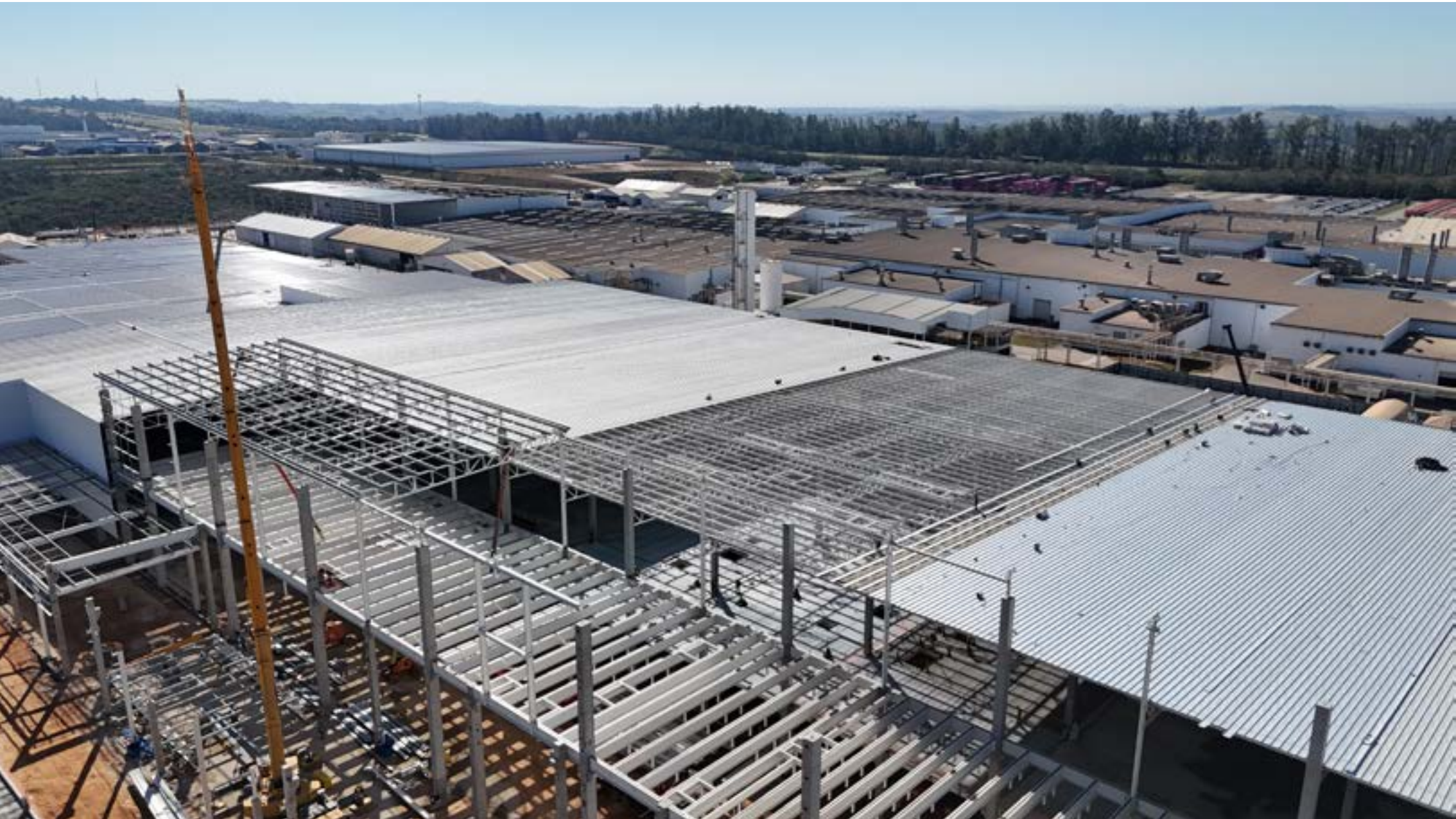
A estrutura de cobertura (acima) é formada por treliças metálicas dimensionadas para vencer grandes vãos com elevada eficiência estrutural e baixo peso próprio. A solução reduz a necessidade de apoios intermediários, amplia as áreas livres para instalação de equipamentos industriais e facilita futuras adaptações das linhas de produção, um dos principais objetivos da ampliação da unidade da Toyota em Sorocaba.
