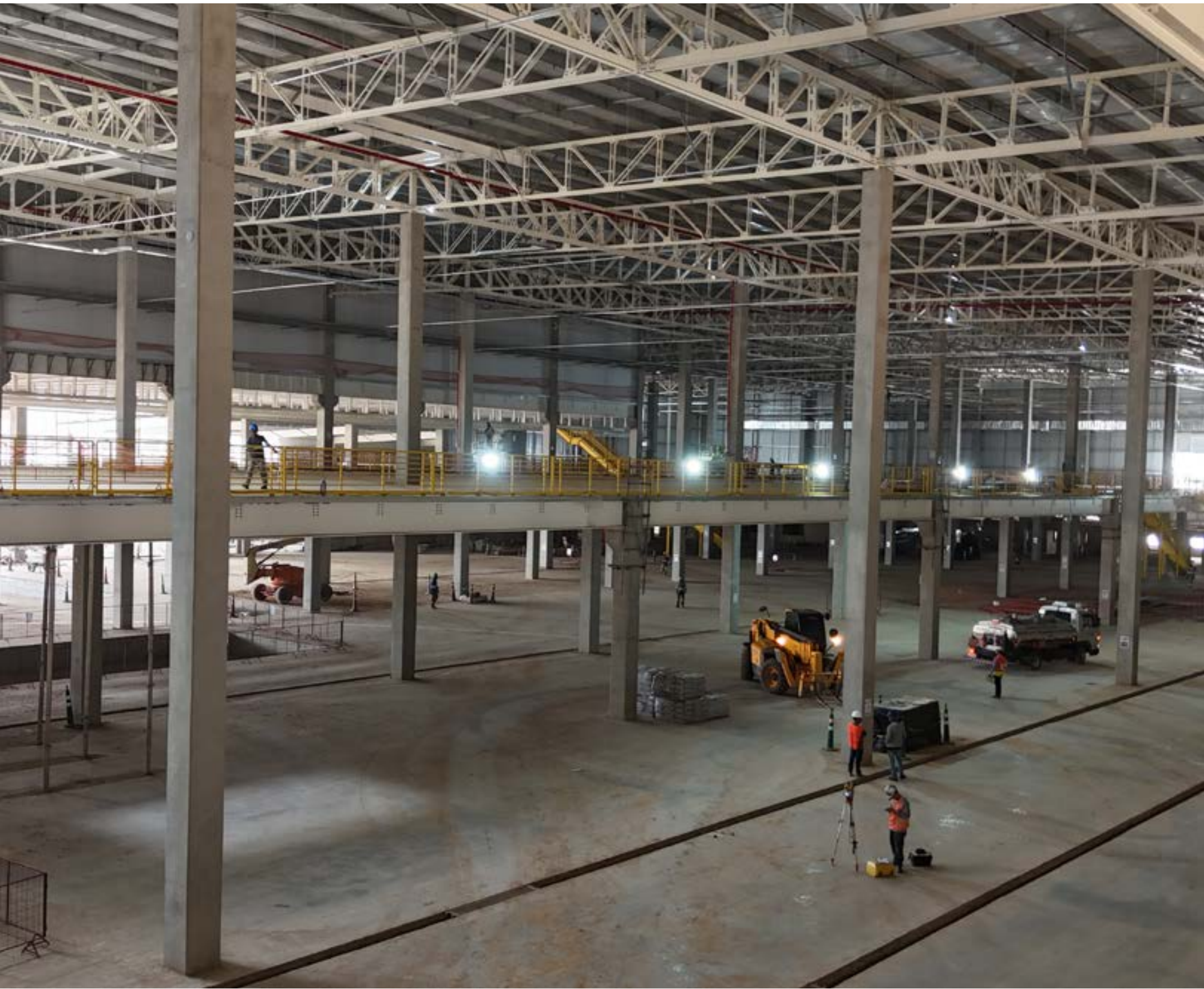
A estrutura de cobertura (acima) é formada por treliças metálicas dimensionadas para vencer grandes vãos com elevada eficiência estrutural e baixo peso próprio. A solução reduz a necessidade de apoios intermediários, amplia as áreas livres para instalação de equipamentos industriais e facilita futuras adaptações das linhas de produção, um dos principais objetivos da ampliação da unidade da Toyota em Sorocaba.
