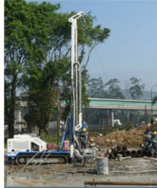
Estaca Raiz Microestaca
