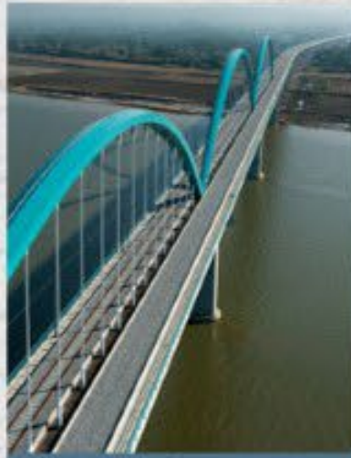
Pontes e Viadutos
