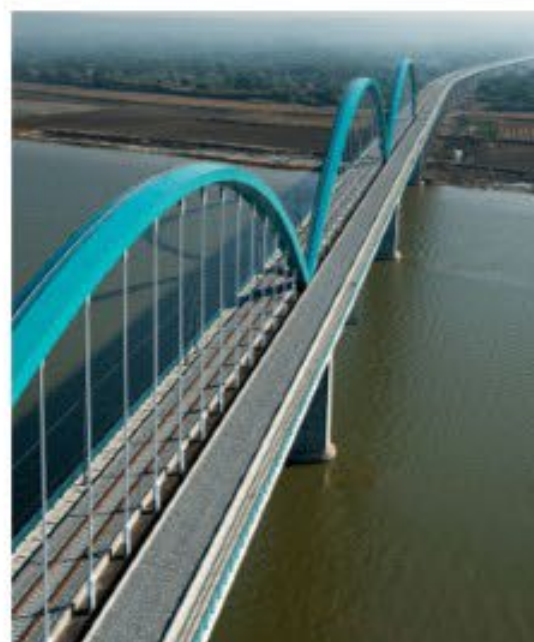
Pontes e Viadutos
