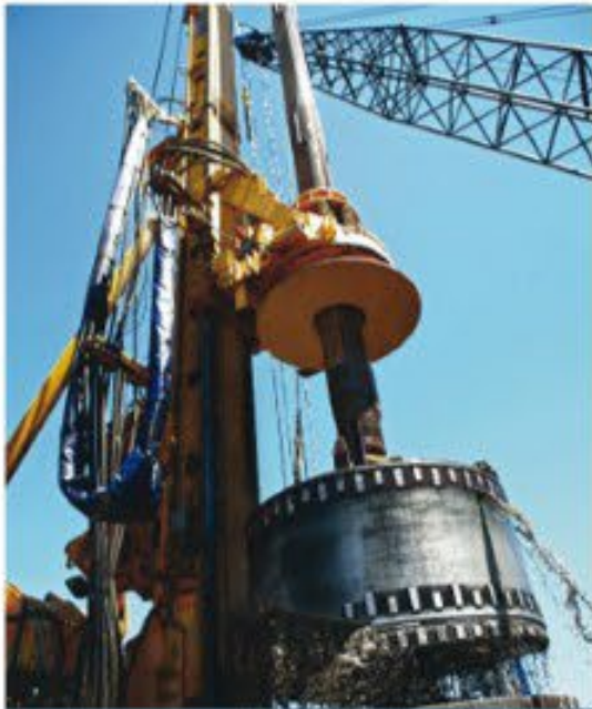
Estaca Escavada de Grande Diâmetro em Solo
