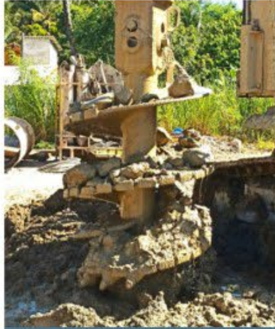
Estaca Escavada de Grande Diâmetro em Rocha
