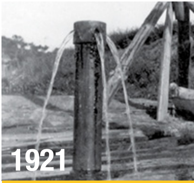
Portugal Captação de águas
