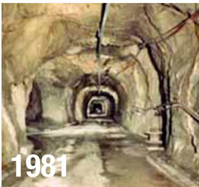
Portugal Obras Subterrâneas
