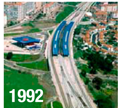
Portugal Obras Ferroviárias
